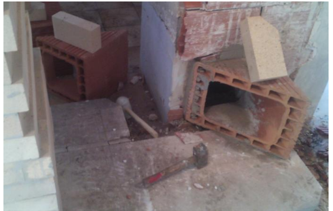
Raccord avec le conduit de cheminée
