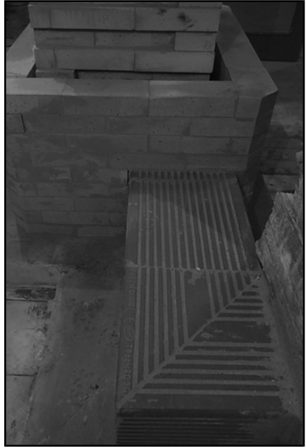
Connexion du poêle au conduit sans et avec banc
