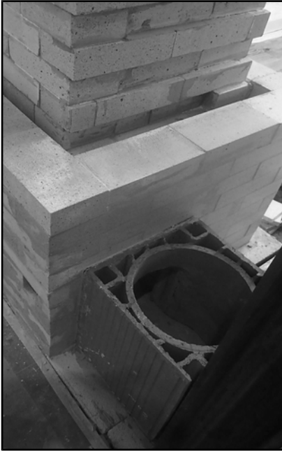
Connexion du poêle au conduit sans et avec banc
